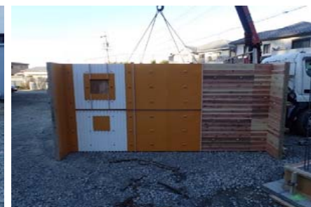
②型枠組立
