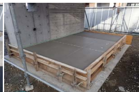
②木目地取付・下地コンクリート打設完了
