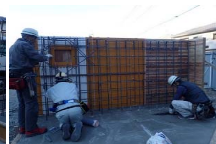
③型枠建込
