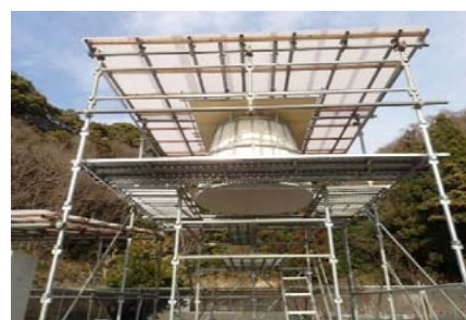
天井ボード組立 (モックアップ)
