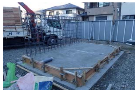
①ベース躯体・鉄筋組立完
