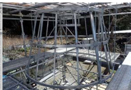
天井LGS組立 (モックアップ)
