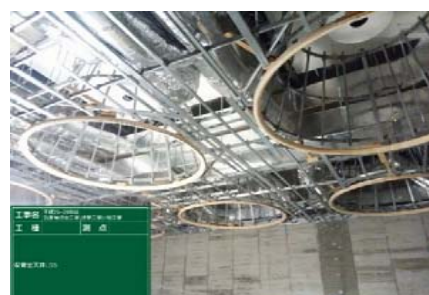
現場施工状況 (LGS)
