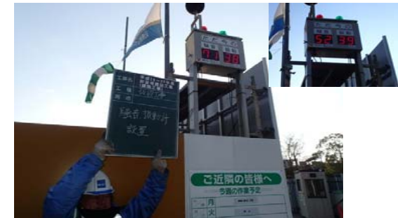
騒音振動計設置状況
