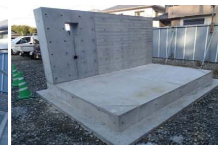
④コンクリート打設完了
