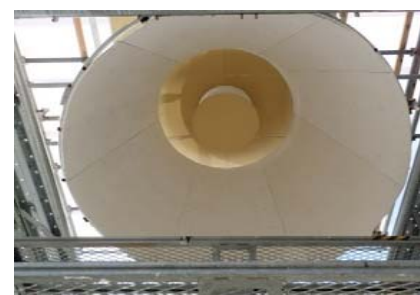
天井ボード組立 (モックアップ)
