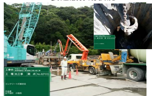
コンクリート打設状況
