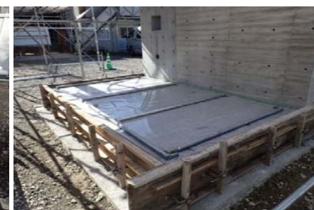
③コンクリート養生状況 (1週間以上)
