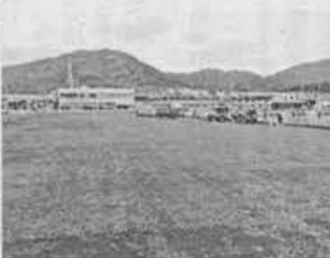
舗装する第1船渠内港西岸壁
