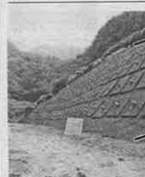
19年度に完了した法面上段。下段の工事では、21年度以降に重方式擁壁工を併用して事業を完了する方針。
