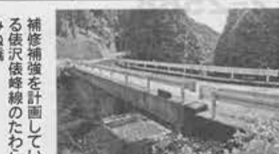
補修補強を計画している依沢依峰線のたわらみね橋
