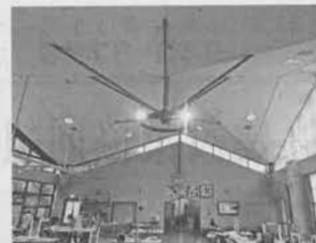
特定天井の改修を行う桜の園ホールの天井。また、張り替えに付随する電気空調衛生などの設備工事も建築一括して発注する予定である。
