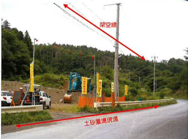
架空線が現場と平行に存在している
