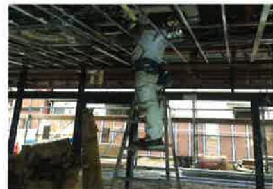
正しい事例 高さに合った脚立を使用
